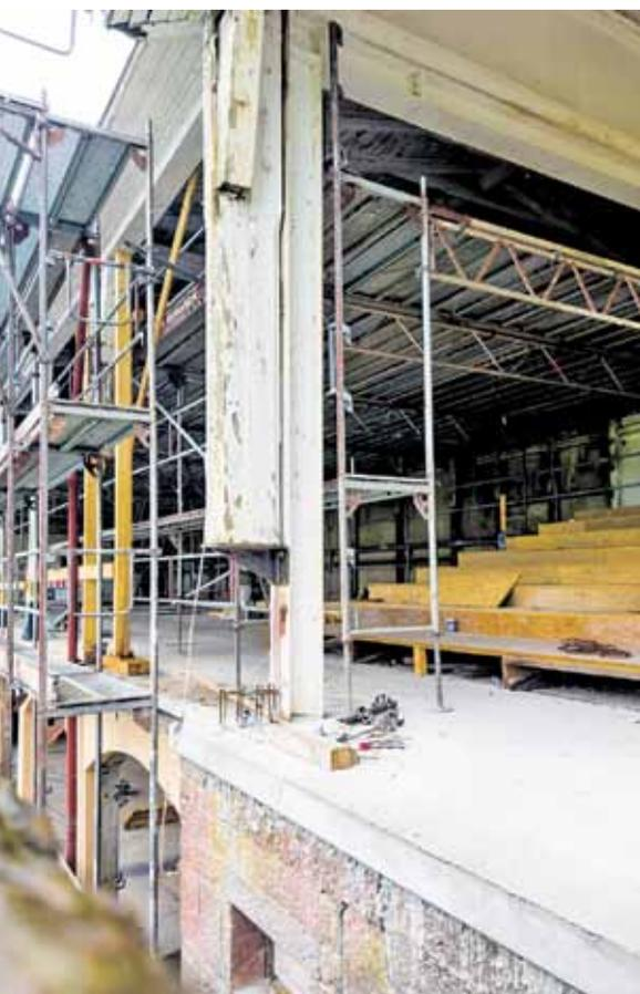
zusätzliches Holzgerüst angebracht. Die ursprünglichen Holzträger waren an der unteren Seite morsch und mussten abgesägt werden. Die Dachkonstruktion „schwebte“ in dieser Zeit. Ein Stahlbetonstreifen, auf welchem die Träger standen, musste abgebrochen werden. Dieser war nicht mehr tragfähig. In diesem Zuge wurden auch die Treppenaufgänge abgebrochen.
