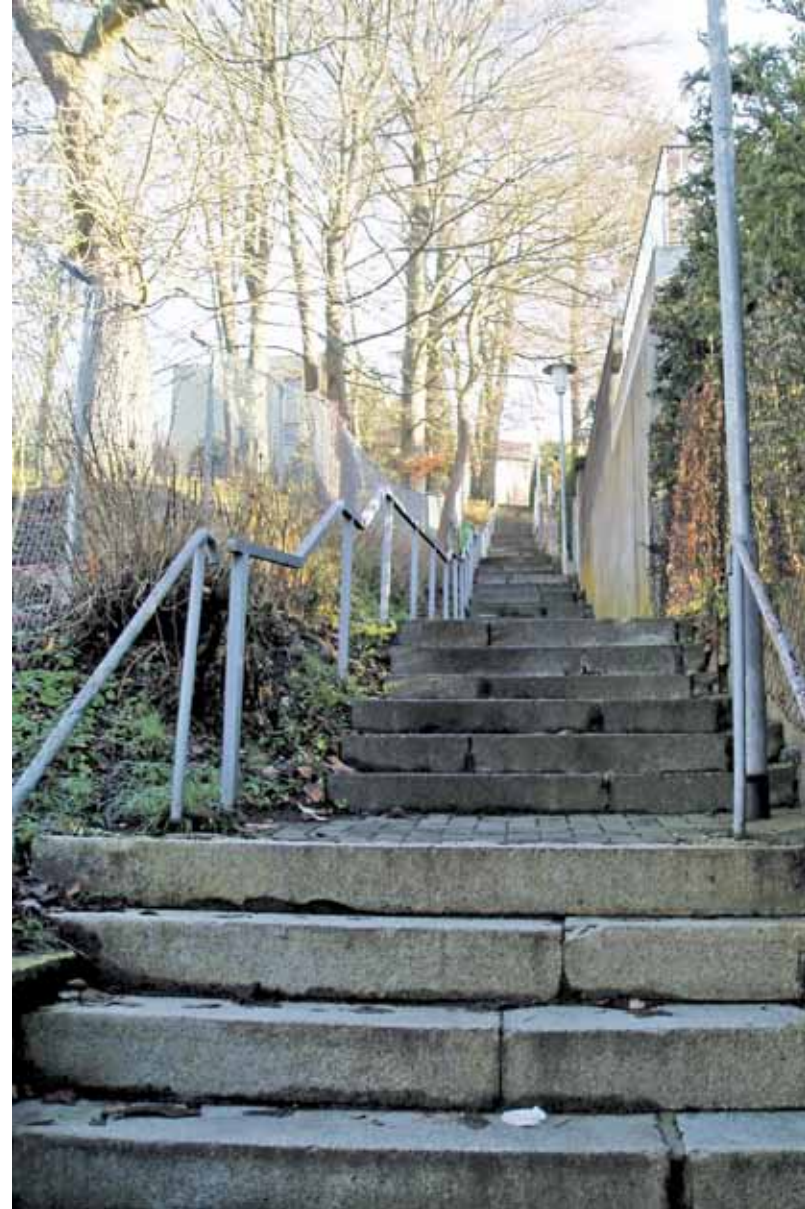
Der Treppenweg zwischen Salinenstraße und Friedrich-List-Straße
